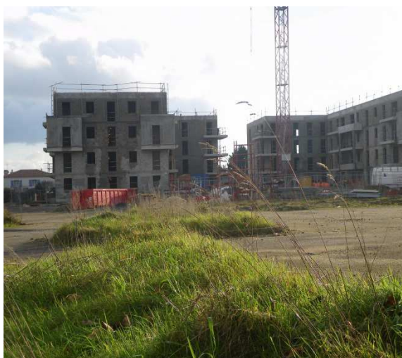
Nouvelle construction de l'Îlot Flora Tristan (ex-Citroën) entre la rue des Naudières et rue Charles Rivière
