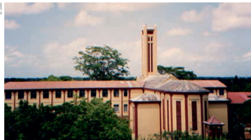
Séminaire St Gall de Ouidah - bâtiment central et chapelle.
