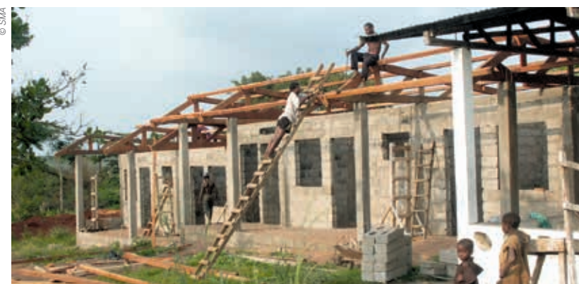
École en construction
